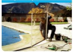
▶ Placer le 1<sup>st</sup> piquet dans le manchon. ▶ Tendre le galon du bas et marquer l'emplacement du trou suivant. ▶ Se servir du filet comme gabarit pour marquer les trous puis percer les trous les uns après les autres.
