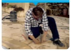
▶ Prendre les mesures de la barrière par rapport au bassin. ▶ Faire un tracé au cordeau afin que les piquets soient alignés. ▶ Marquer au stylo l'emplacement du trou à percer.
